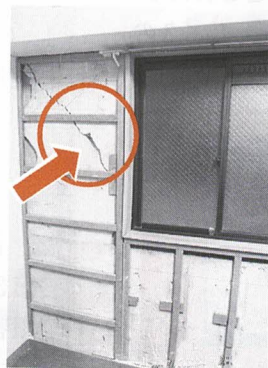
写真 地震ひび割れ補修工事の例 共用廊下外壁よりポリマーセメントモルタル充填になっているが、内側の断熱材を剥いだ状態でモノサシが12cm（矢印から）挿入された。壁厚15cmなのでエポキシ樹脂は3cmしか充填されていない（充填率目標70%には到底達していない。）
